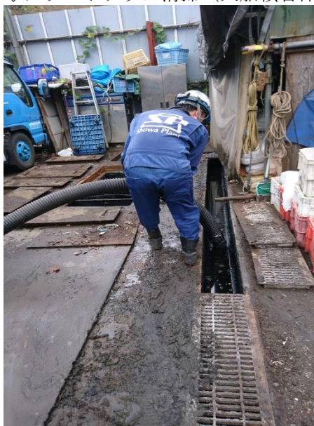
◇グリストラップ清掃（大船積替保管場）
