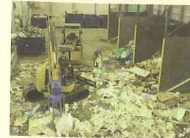
搬入した廃棄物を重機で荒選別
